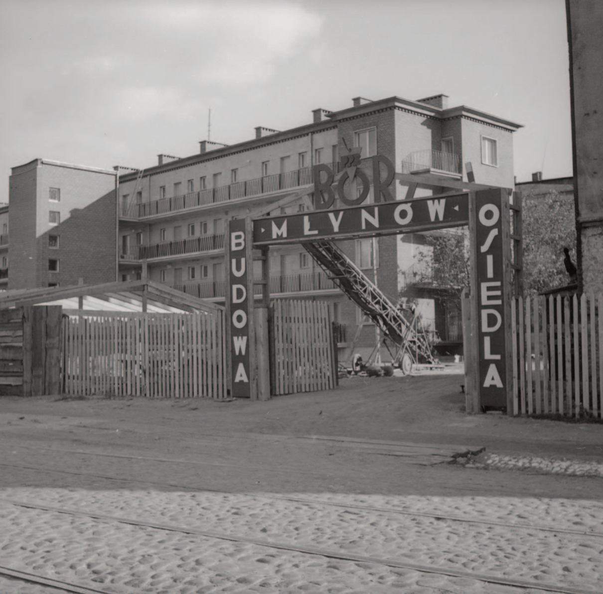
Budowa osiedla Młynów przy ul. Górczewskiej na warszawskiej Woli, 1949. Fot. NAC
