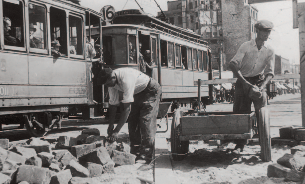
Robotnicy podczas brukowania ulicy Marszałkowskiej, w tle ruiny kamienicy spółki Siła i Światło przy ul. Marszałkowskiej 94 róg Nowogrodzkiej 30, 1948. Fot. NAC
