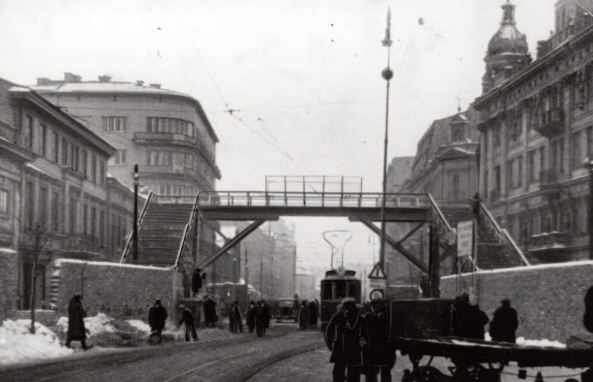
Most nad ul. Chłodną łączący dwie części getta, luty 1942. Fot. NAC
