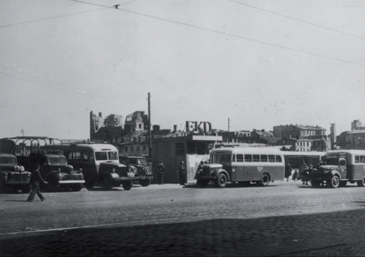
Prowizoryczny dworzec autobusowy Elektrycznych Kolei Dojazdowych (EKD) w Alejach Jerozolimskich naprzeciwko hotelu Polonia – widoczne ciężarówki przerobione na autobusy, 1947. Fot. NAC
