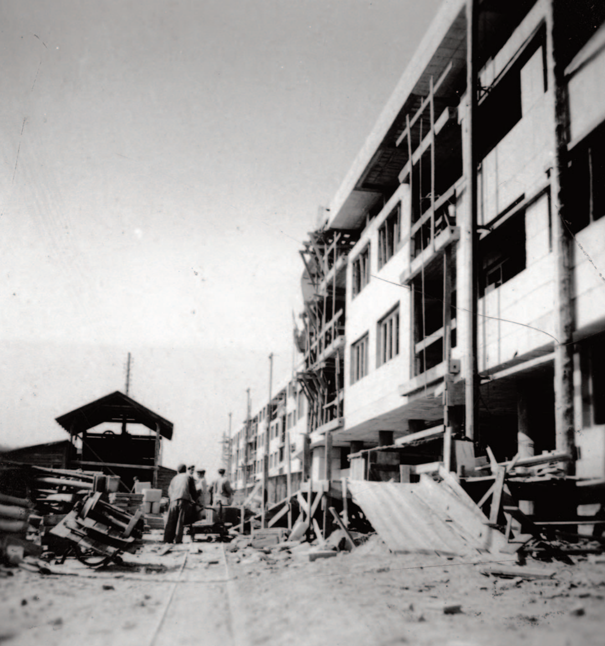
Osiedle WSM Koło-Wschód, blok przy ul. Ringelbluma 2 podczas budowy. Z lewej pod zadaszeniem maszyna do kruszenia gruzu (domy wznoszono z wytwarzanych na miejscu bloczków z gruzobetonu), 1948. Fot. NAC
